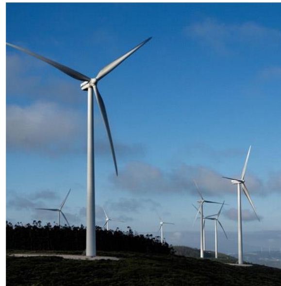
Vestas V90-3MW wind turbine http://www.vestas.com/
